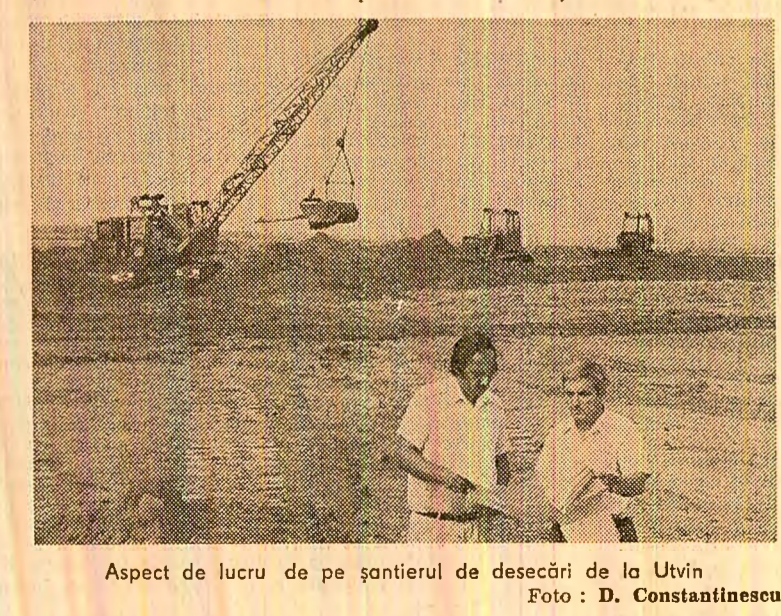
Aspect de lucru de pe șantierul de desecări de la Utvin. Foto: D. Constantinescu
