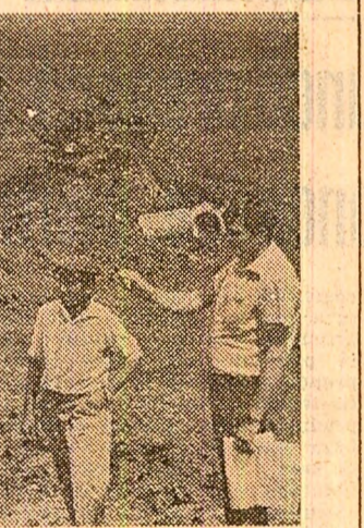
Aspect de pe șantierul sistemului de desecare Moravio, județul Timiș
