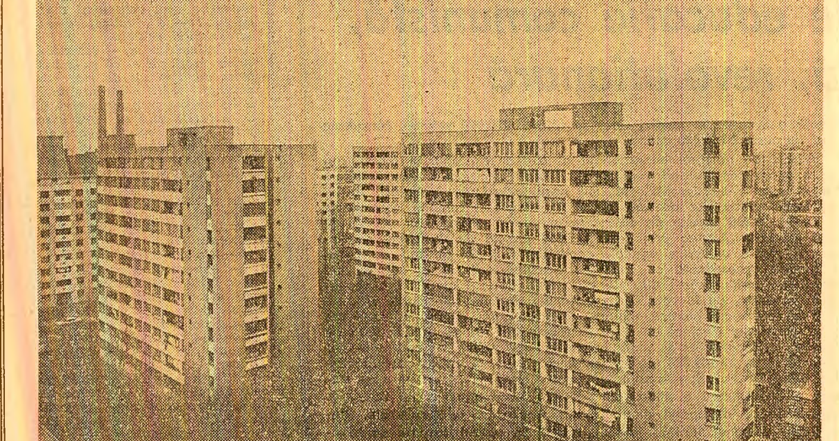
Din noile construcții de pe strada Fizicienilor din București Foto: Sandu Mendrea
