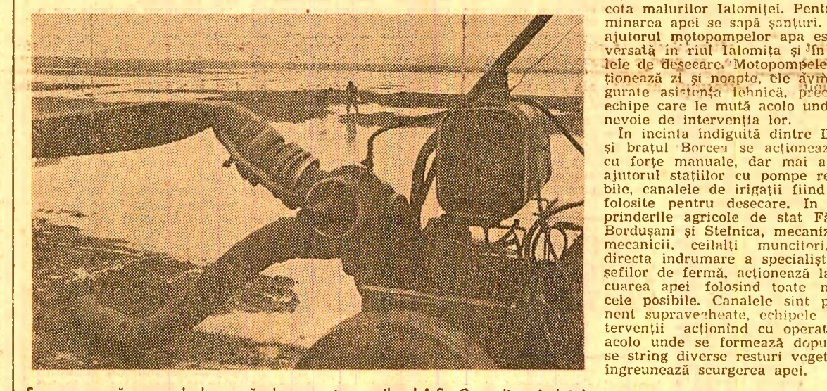
Se evacuează excesul de apă de pe terenurile I.A.S. Crevedia, judeţul Dimboviţa. Foto: D. Constantinescu
