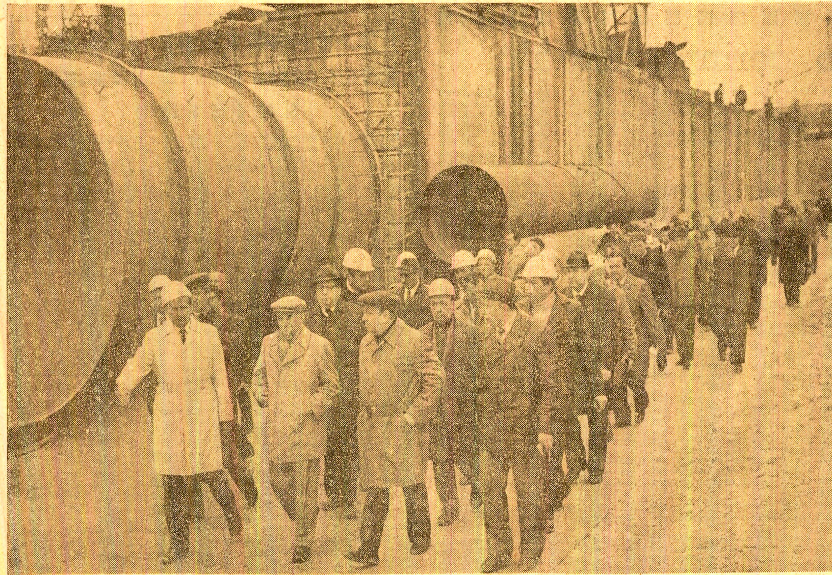
Pe șantierul Centralei nucleare-electrice de la Cernavodă
