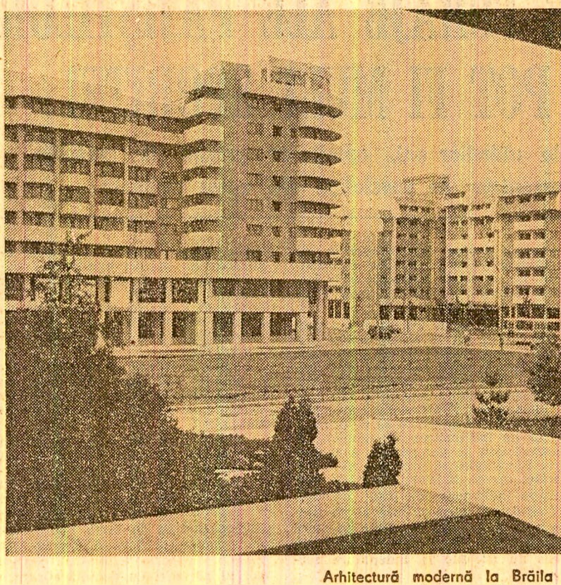
Arhitectură modernă la Brăila
