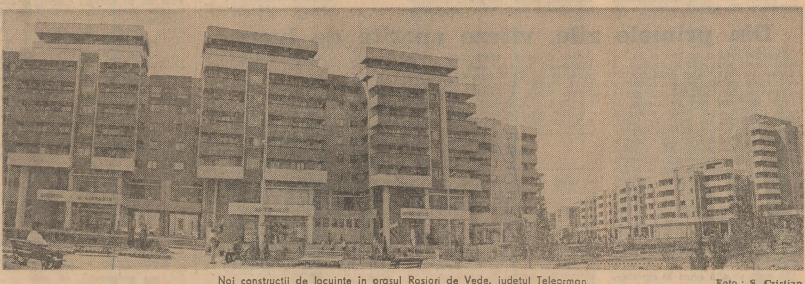
Noi construcții de locuințe în orașul Roșiori de Vede, județul Teleorman
