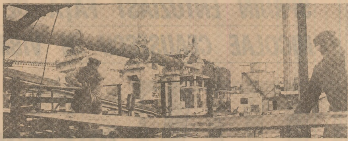
Pe șantierul noii secții de sinterizare din cadrul Combinatului de aluminiu Oradea se montează instalatiile. Foto: Sandu Cristian
