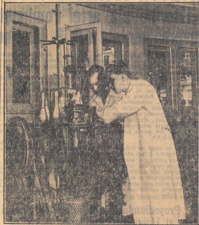
Colectivul de mecanisme al Institutului de mecanică aplicată al Academiei R.P.R. a făcut cercetări asupra mașinilor circulare automate de tricotat în vederea mării vitezei de lucru. In fotografie: Ing. Eug. Bugalevici și Ing. Cristian Pellicudi studind mașina în timpul lucrului.
