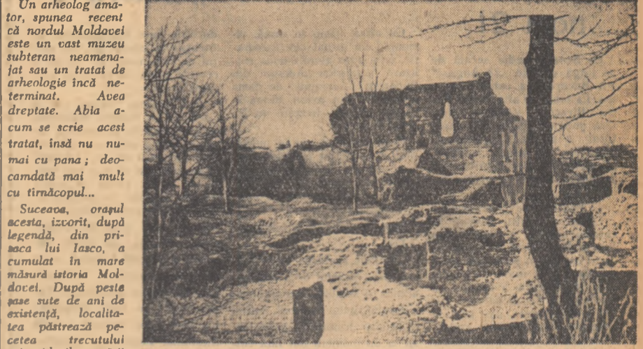
Vedere de la cetatea Sucevei
