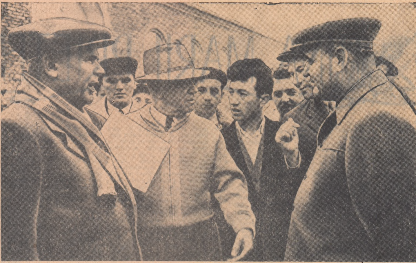
Tovarășii Gh. Gheorghiu-Dej, Chivu Stoica și Emil Bodnăraș în mijlocul muncitorilor și cadrelor de conducere de la centrala electrică de termoficare Borzești
