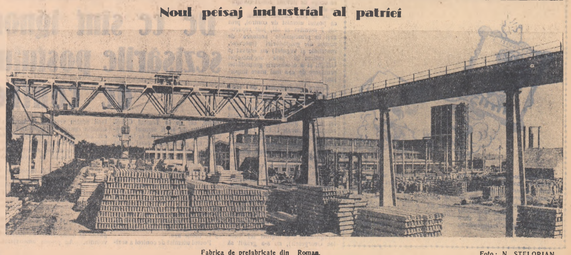
Fabrica de prefabricate din Roman. Foto: N. STELORIAN
