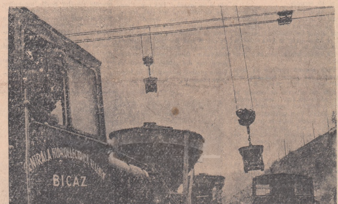
Utemistul Adalbert Benosi, conducător de locomotivă la grupul de șantier al fabricii de betoane din Bicăz este fruntăș în producție. Iată-l în fotografie conducînd transportul betonului de la fabrică spre macaralele funiculare. Foto: D. F. DUMITRU
