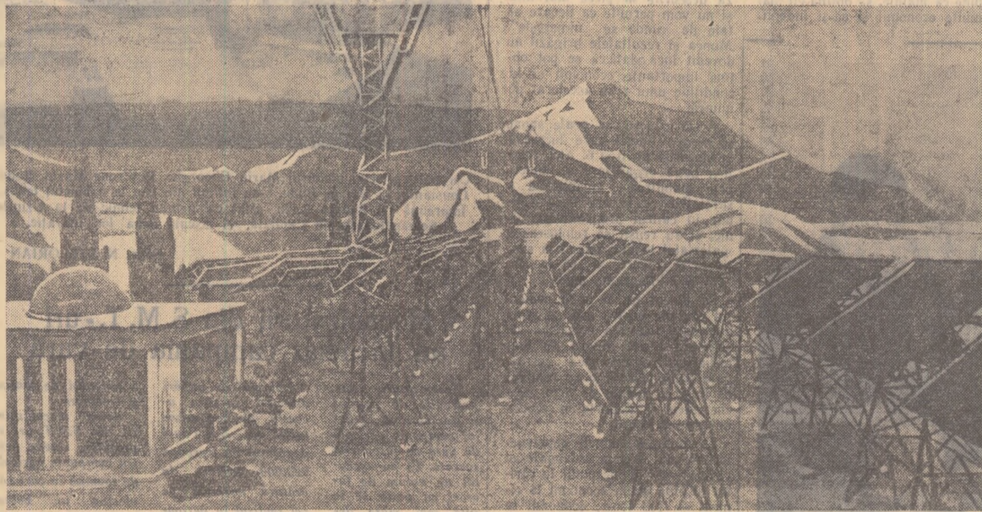
Acest model al unei heliocentrale constituie o adevărată oază pentru razele solare. Oglindzile captează razele solare pe care le transformă cu ajutorul unor semiconductori pe bază de siliciu în energie solară. Oglindzile se orientează în mod automat spre soare. Acest mod de transformare a energiei va avea un mare rol în industria viitorului precum și pentru fertilizarea unor deșerturi.
