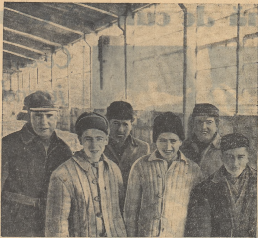
Pe șantierul fabricii de mobilă din Codlea, brigada de dulgheri condusă de Matei Knochner realizează însemnate economii prin folosirea prefabricatelor...
