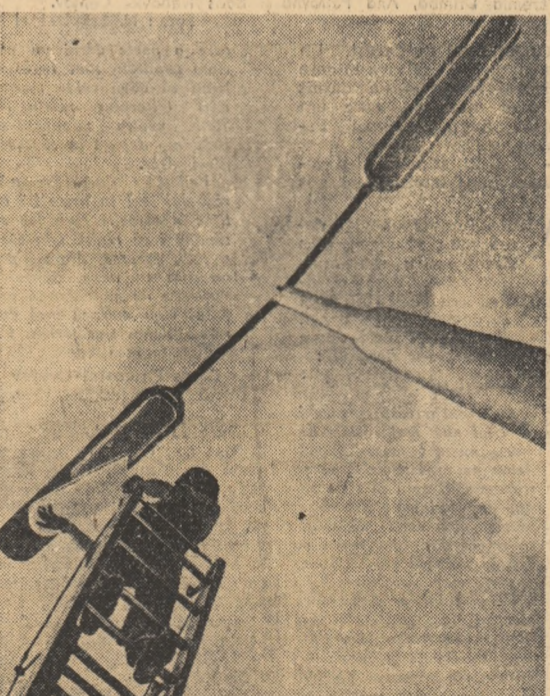
Lumină fluorescentă la Sotu-Mare.
