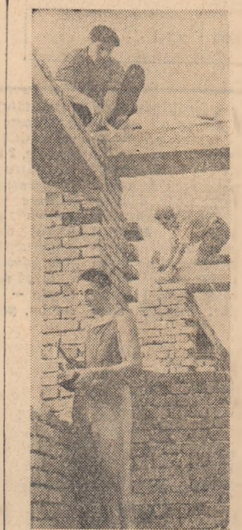
Echipa de zidari condusă de Bacu Carol de pe Șantierul de construcții Onesti a lucrat înaltivă de a economisi 10 cărămizi la un metru cub de zidărie. Foto: A. FOCSA
