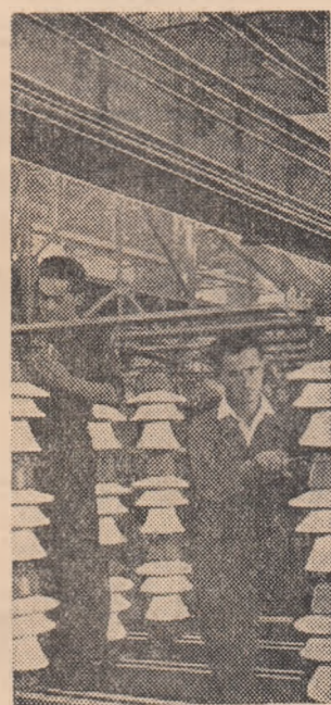
Uzina „Electroputere”-Craiova. Liceu Gh. Șeul echipei de montaj și Săcămou Iulian, execută montarea separatorilor tripolari de 110 K. V.
