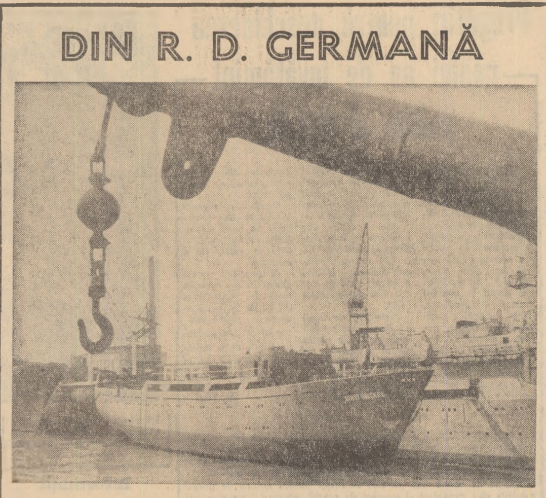
Aspect parţial al importanţului şantier naval Mathias-Thesen din Wismar (R. D. Germană).
