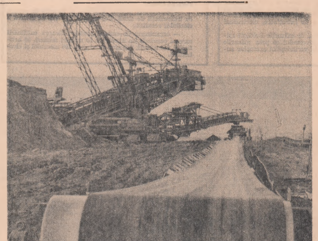
Bandă transportoare în funcțiune pe șantierul centralei electrice „Adamov” din R. P. Polonă. Foto: C.A.F.-VARȘOVIA
