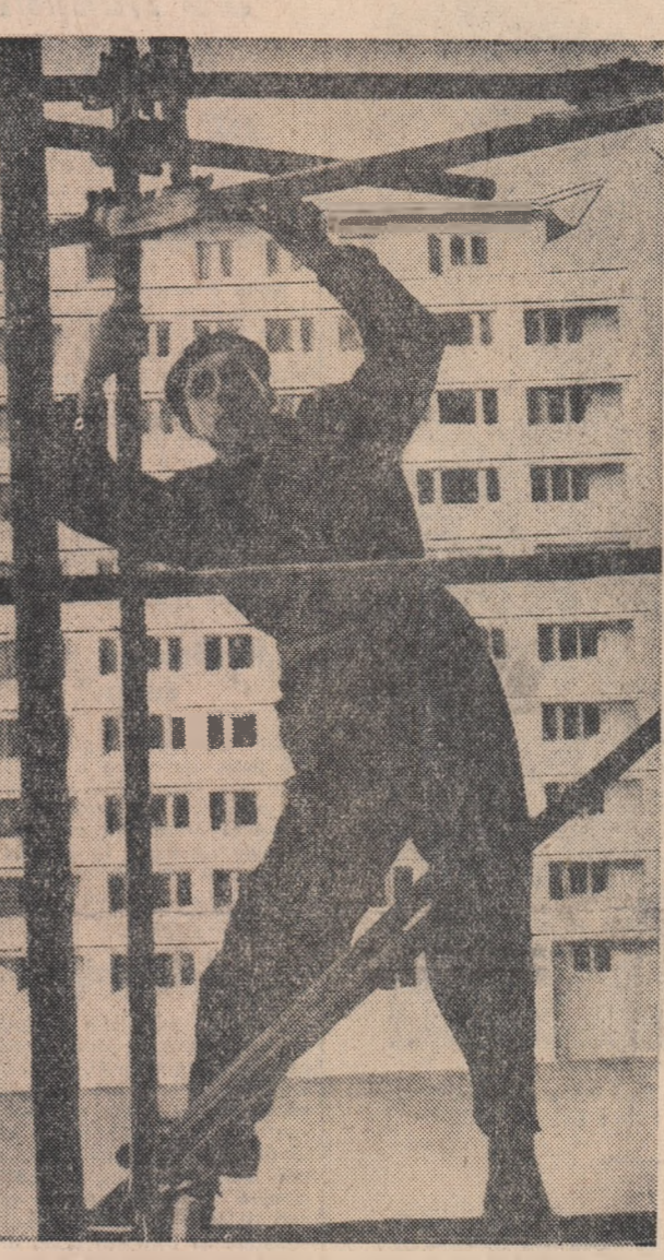
Schele se dau jos și un nou bloc își arată strălucirea. Construcțiile din Ploiești au acordat o mare atenție calității lucrărilor de finisaj. Foto : AGERPRES
