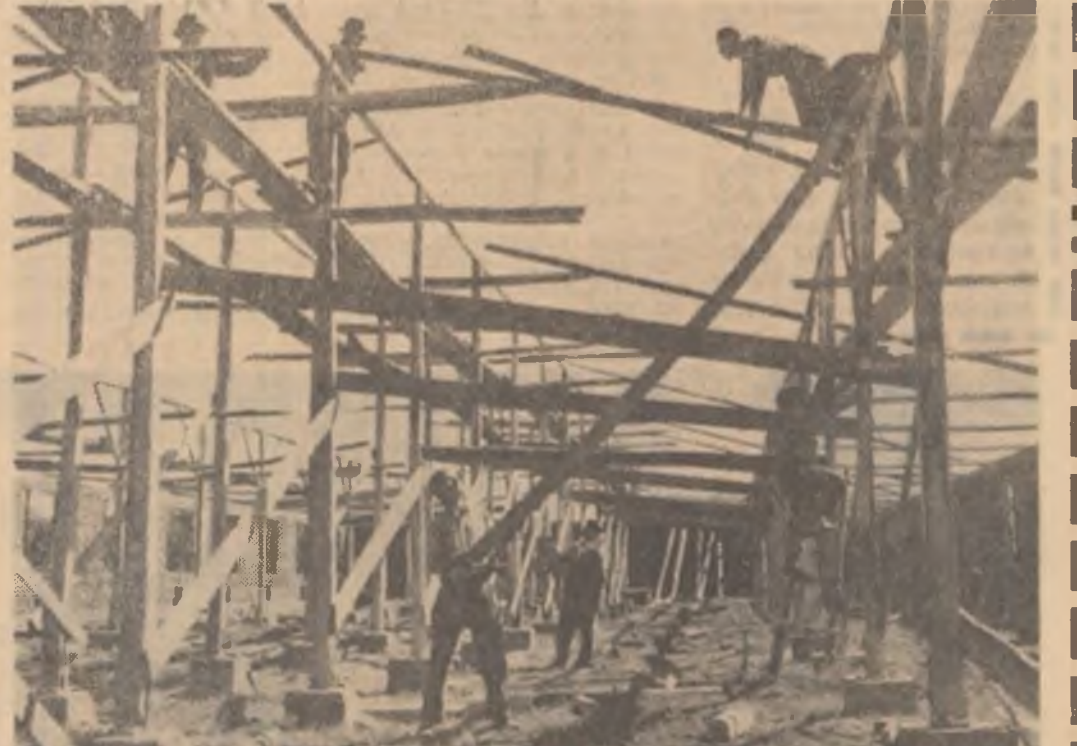
Paralel cu celelalte munci din actuala campanie agricolă, colectivitățile din comuna Adunați-Copăceni, regiunea București sînt preocupate și de terminarea într-un timp cît mai scurt a construcțiilor zootehnice. Dulgherii lucrează acum la noua hală pentru 5000 de păsări. Foto: AGERPRES
