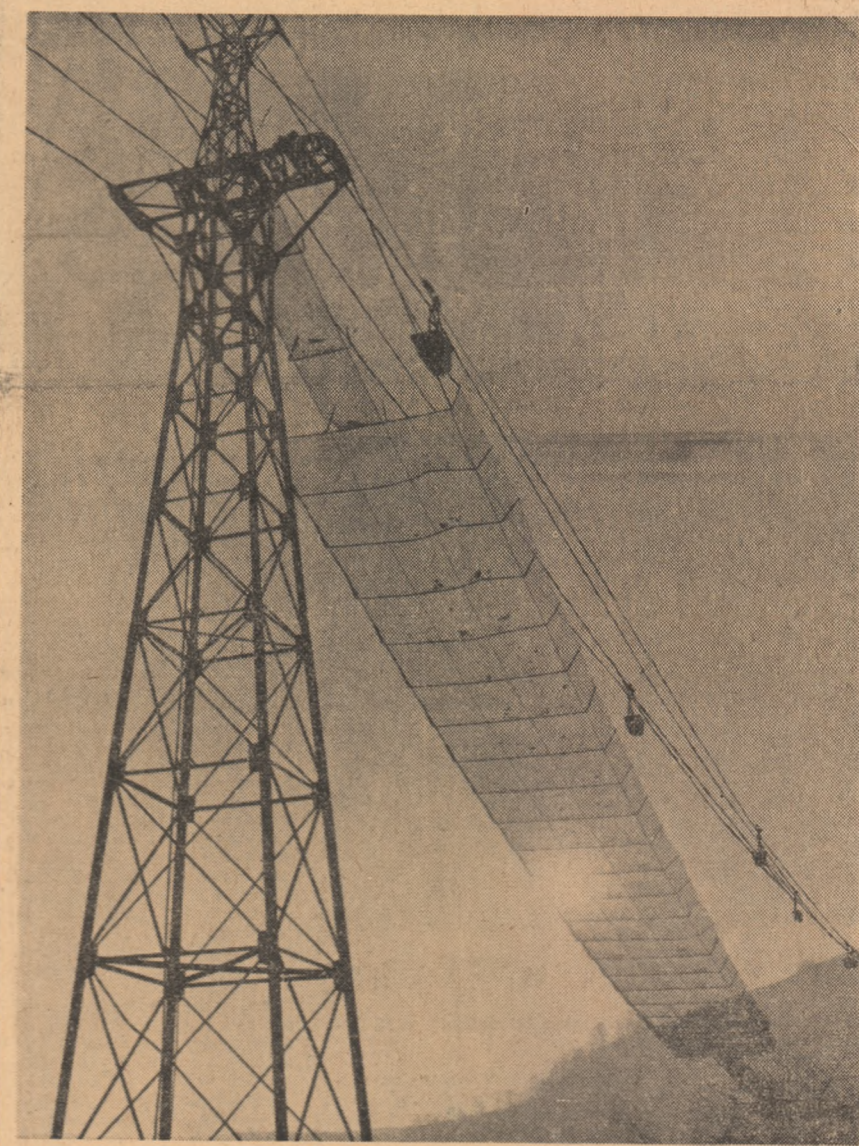
Zi și noapte, într-un continuu du-te-vino, luncurile din Valea Jiului, transportă cărbunile spre stațiile de preparare.
