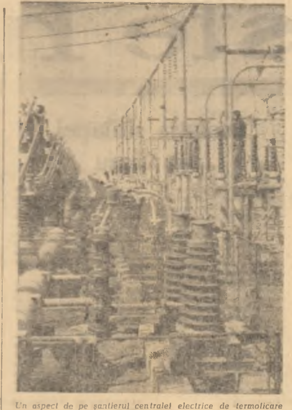
Un aspect de pe șantierul centralei electrice de termocărbune de la Craiova.
