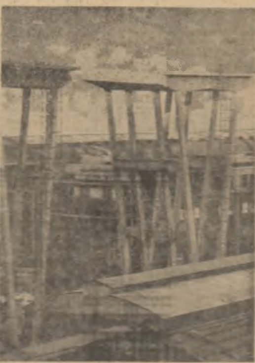
ITALIA. La Genova s'inceput de curind constructia unui viaduct de 1 km de lungime pentru a descompensa, scindind în doi strazi ai „Lombardi Liguri”. În fotografie: Aspect al viaductului în construcție.
