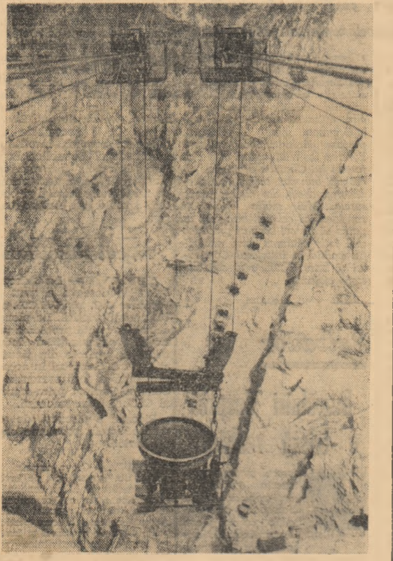
O nouă benă pentru îndalarea barajului Hidrocentralei „16 Februarie” de pe Argeș
