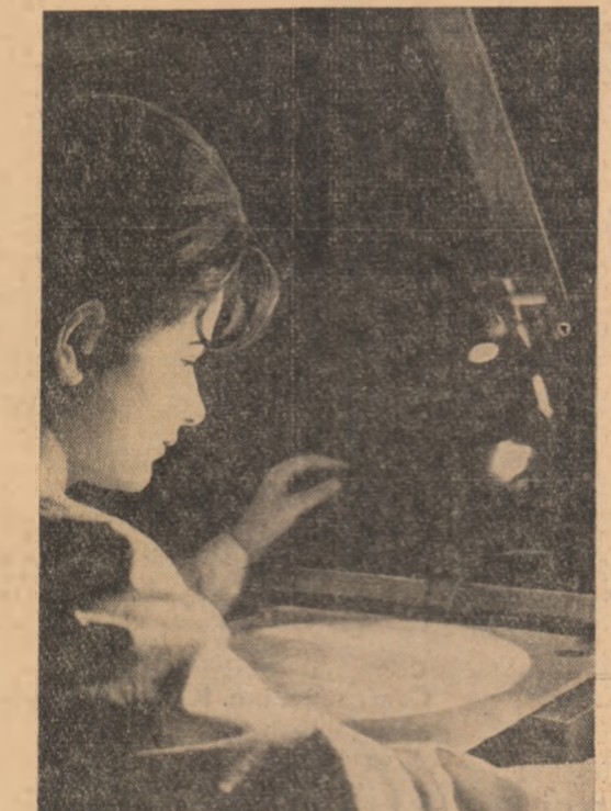
Cercetare științifică — dar nu la Institutul de cercetări ci, în cercul științific studentesc. Studenta Mariana Proșleanu din anul II al Facultății de fizică, Universitatea din Timișoara, analizează spectrul de emisie a fierului cu ajutorul proiectoarelor de spectru. Foto: AGERPRES
