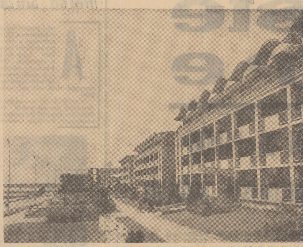
Noi construcții în Mangalia
