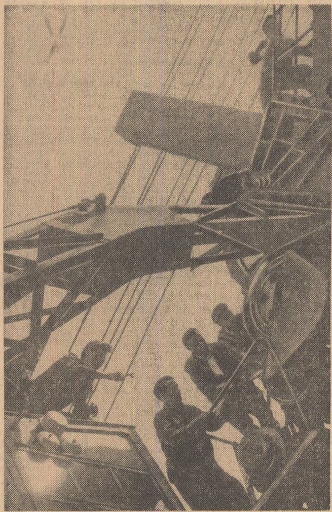
Excavatoare în construcție. Foto: ION CUCU
