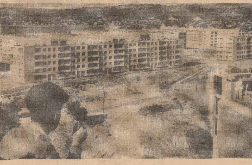
ORADBA: Un nou cartier de locuințe în construcție
