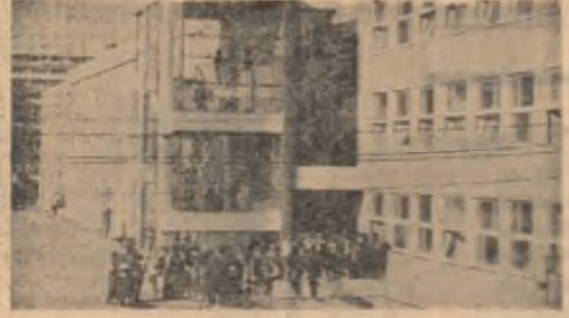
Într-o pauză, la noul complex școlar
