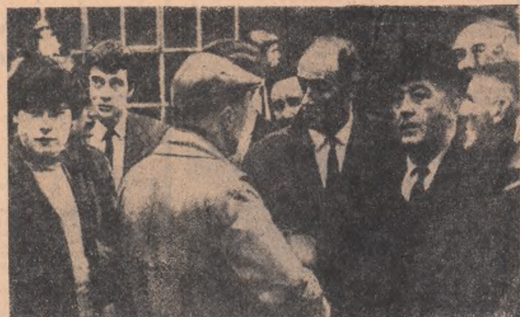
Grup de muncitori constructori greviști din Londra exprimându-și hotărârea de a continua greva, în fața reprezentanților companiei de construcții.
