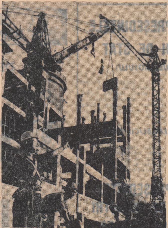
R.P.D. Coreeană. Pe șantierul Combinatului de îngrășăminte chimice Hungnam
