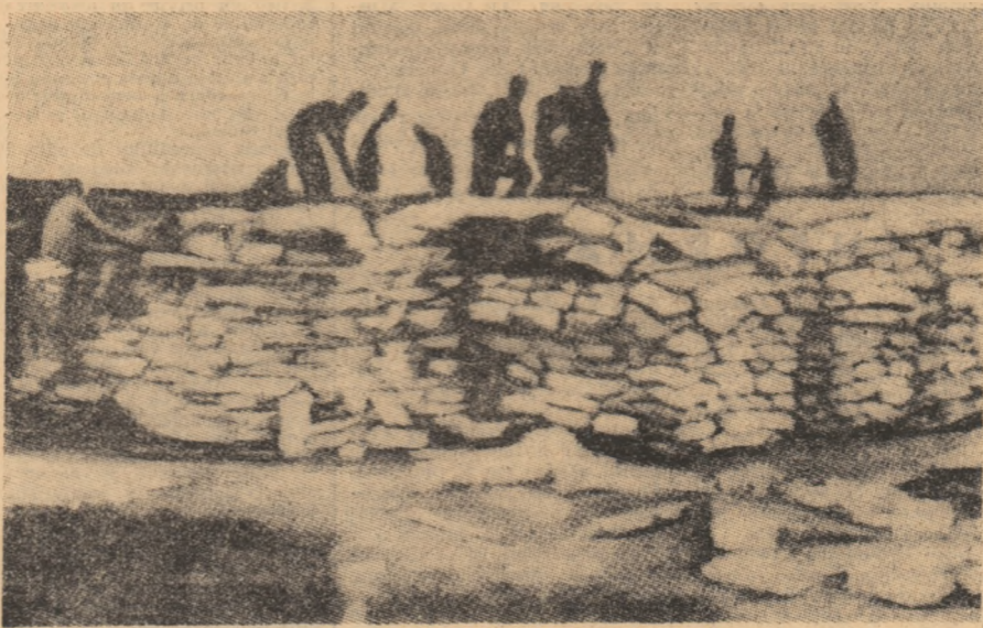
Aspect de la evacuarea bazei Khe Shan. Militari americani demolind întăririle fostelor fortificații.
