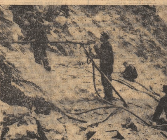
Minerilor din brigada lui Nicolae Ilie, lucrând la excavația nucleului de argilă în malul stâng al barajului hidrocentralei Lotru
