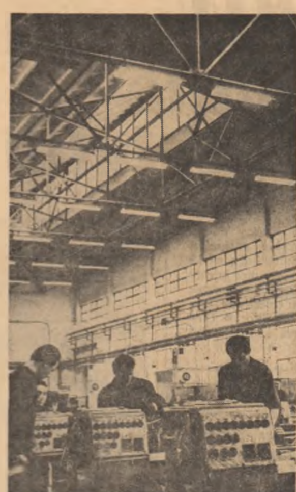
In sectia 3 montaj a Uzinei de strunguri din Arad, tinerii montori definiteaza un nou lot de strunguri revolver...
