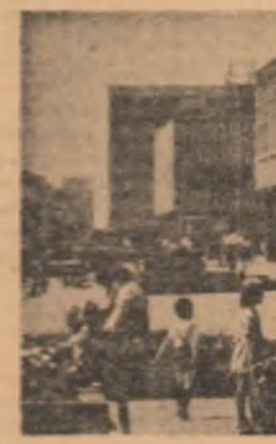
R. D. GERMANĂ. Blocuri noi de locuințe la Magdeburg
