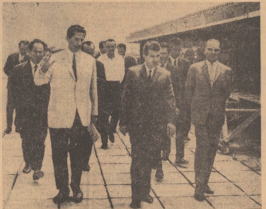
Pe șantierul taberei de copii de la Năvodari.
