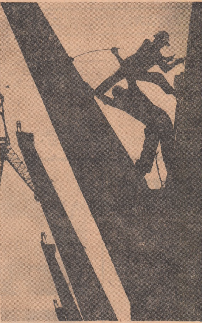
În cursul, o nouă construcție se adăuga la tezaurul edililor al patriei. Foto: ION CUCU
