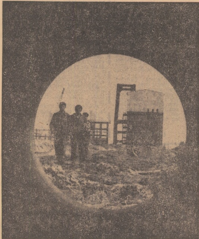
Vedere parțială a Combinatului chimic de îngrășăminte azotoase-Slobozia, obiectiv industrial aflat în construcție. Foto: I. CUCU
