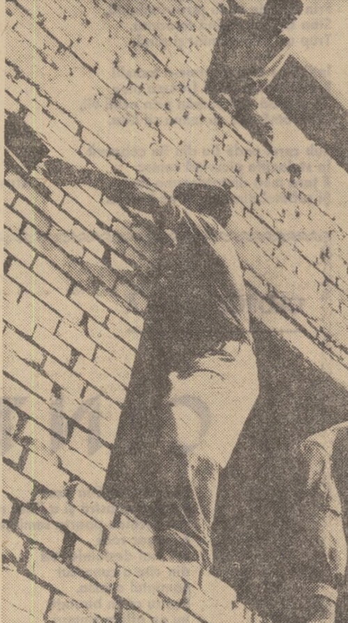
Pe șantierul reconstrucției, la Medias. Foto: C. CIOBOATA
