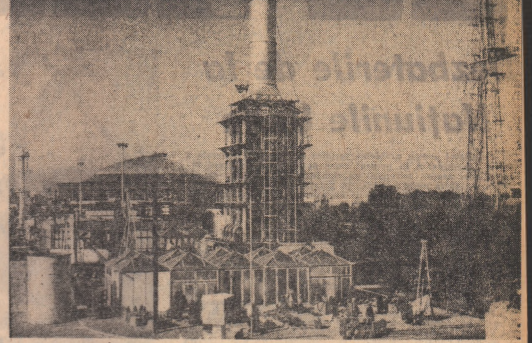
O parte din exponatele românești, dominate de turba instalației F 320 — 3 DH și silueta cazanului de 100 Giga-calorii
