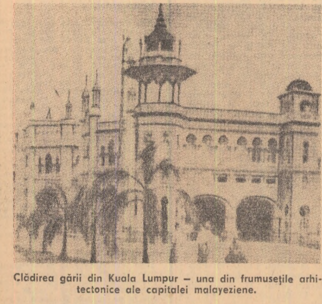
Clădirea gării din Kuala Lumpur — una din frumusețile arhitectonice ale capitalei malayziene.
