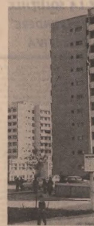
Construcții moderne în municipiul Sf. Gheorghe
