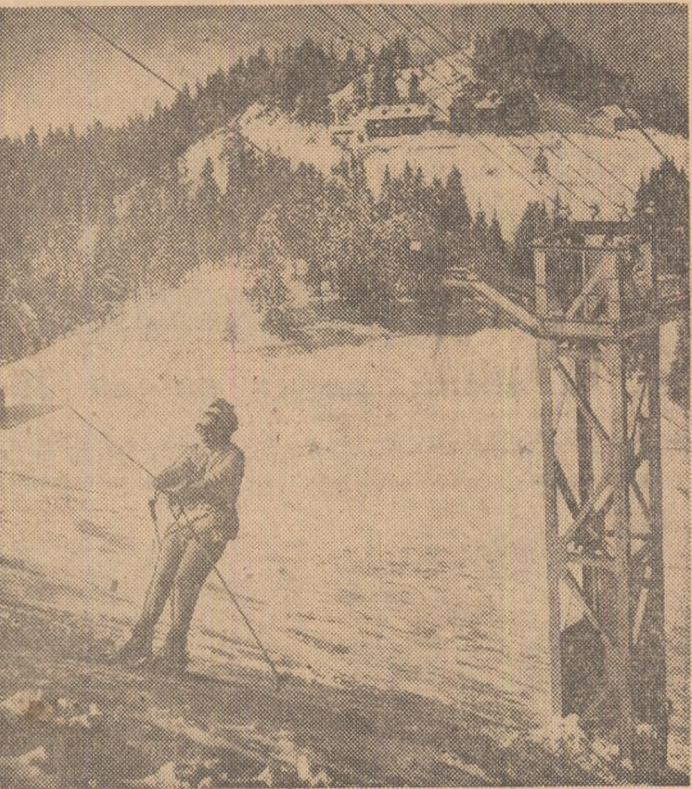
Schlift modern în masivul Postăvarul
