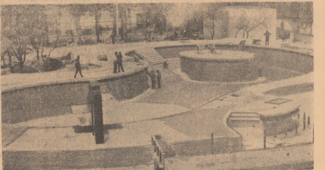
Nova piscină aflată în construcție lângă hotelul „RIVIERA” din Mamaia va îmbogăți litoralul din punct de vedere estetic, dar nu și sportiv
