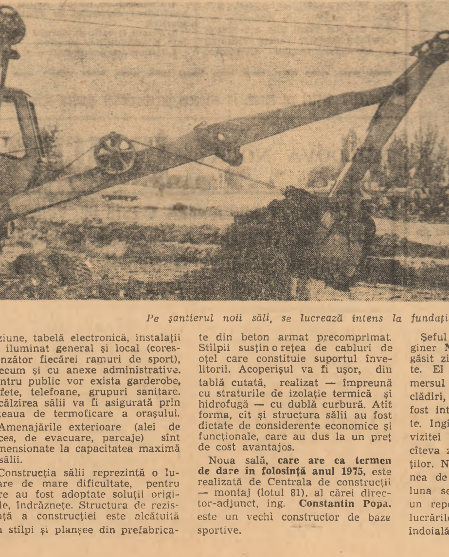
Pe șantierul noii săli, se lucrează intens la fundații
