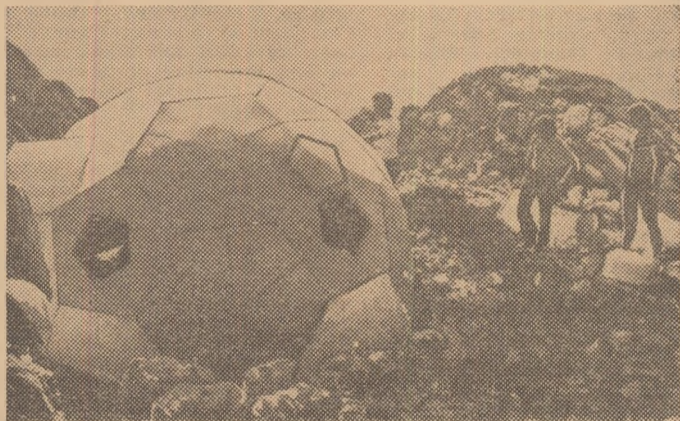
Refugiul de la Virful Ascutit din masivul Piatra Craiului, realizat din masă plastică armată cu fibre de sticlă ignifugate și reflectorizante.
