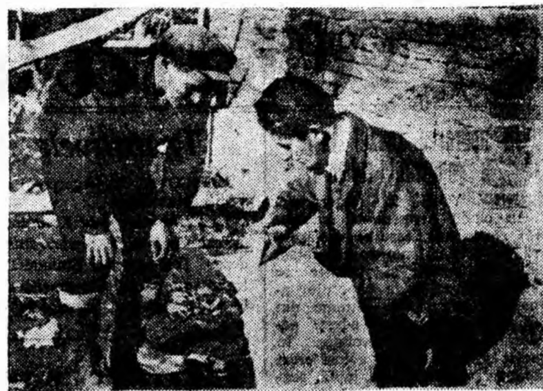
La școala din Uricani, care se află în construcție, zilele trecute au început lucrările de instalare a conductelor de apă. Din grupul de tineri instalatori face parte și utemistul Olaru Ioan care a fost surprins de obiectivul fotografic studiind schița de instalație sanitară a școlii împreună cu ucenicul Androne Viorel. ÎN CLIȘEU: De la stînga la dreapta — Androne Viorel și Olaru Ioan.
