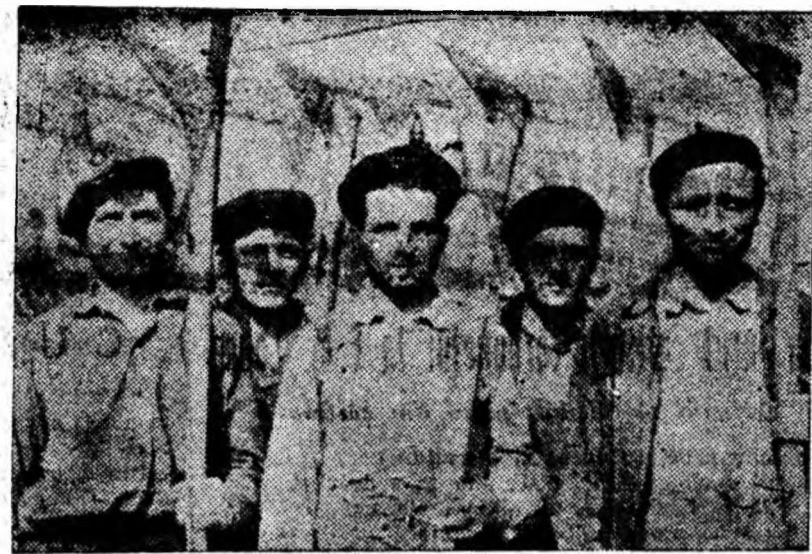
Echipe de țapinari de la depozitul de lemn al minei Petrila condusă de comunistul Crețescu Nicolae își depășește lunar planul de încărcări-descărcări cu 25-30 la sută. IN CLIȘEU: Echipa de țapinari împreună cu șeful ei.
