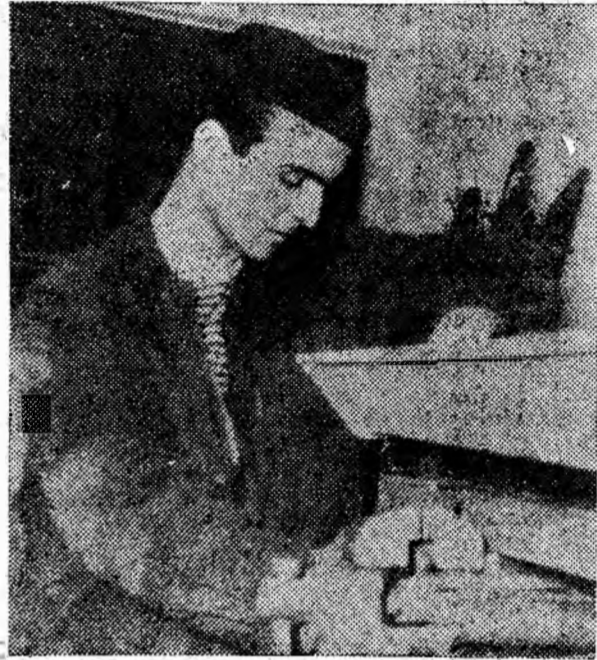
Intr-unul din atelierele termocentralei Paroșeni tinărul Ghionea Dumitru execută o lucrare „specială”. E vorba de lucrările premergătoare instalării luminilor fluorescente în termocentrală.
