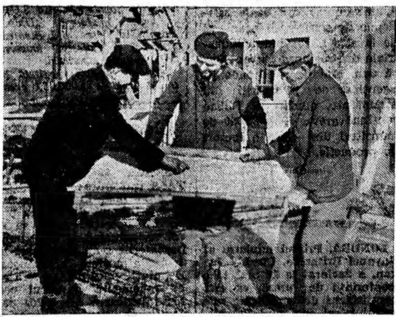
La construcția noului amfiteatru de la Institutul de mine din Petroșani, o contribuție însemnată aduc fierar-betonisti din brigada tov. Ciungulescu Marin. IN CLIȘEU: Sus, pe unul din planșurile clădirii, maestrul Albu Constantin studiază împreună cu fierar-betonistii Ciungulescu Marin și Horvath Ludovic planurile de armături metalice.
